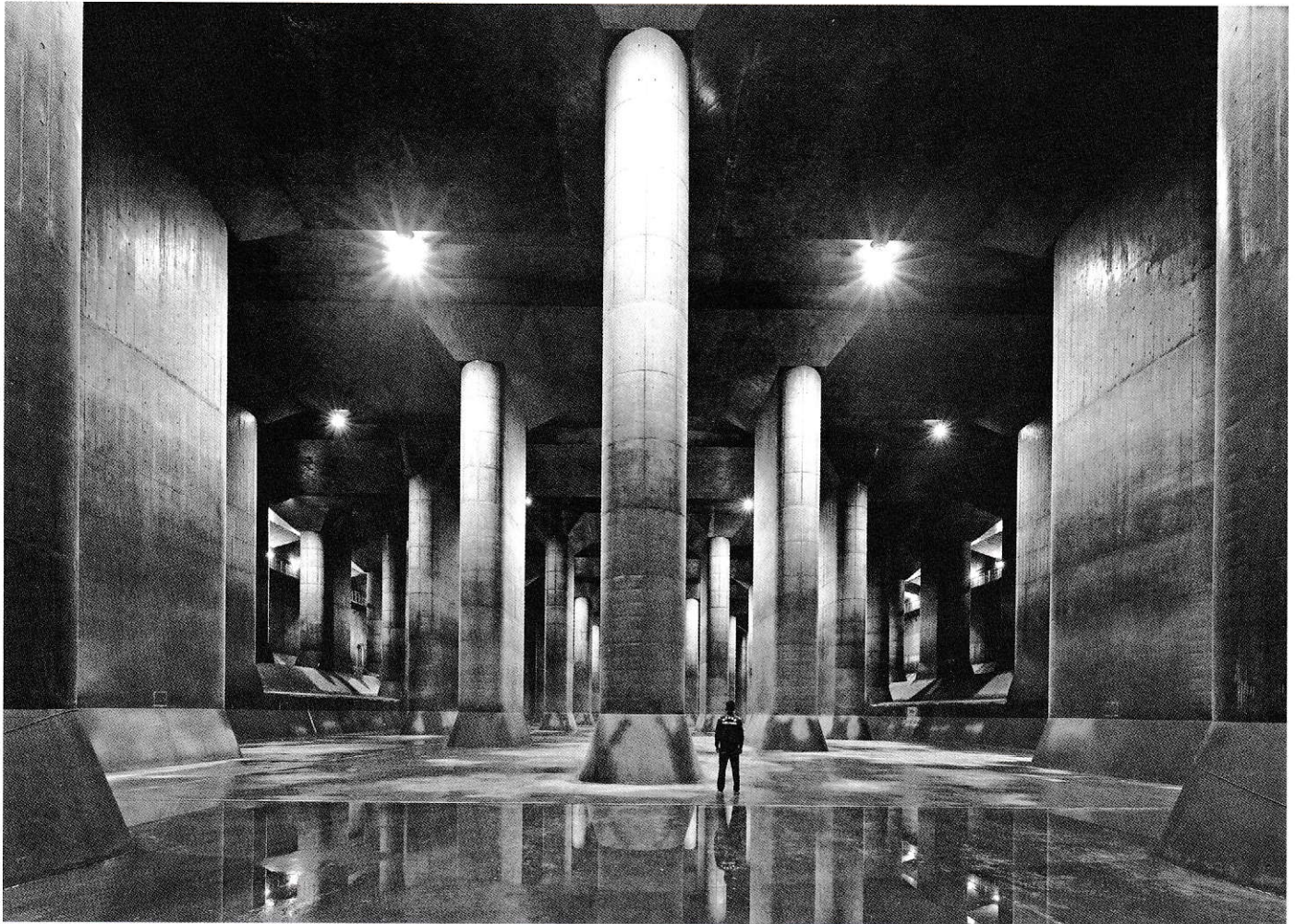
首都圏外郭放水路の地下神殿(通称) 提供 国土交通省江戸川河川事務所
